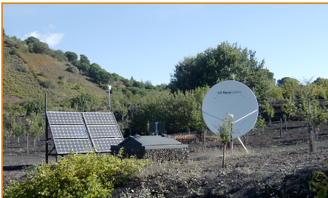
Stazione sismica multi parametrica per lo studio dell'Etna presso la sede Ente Parco
